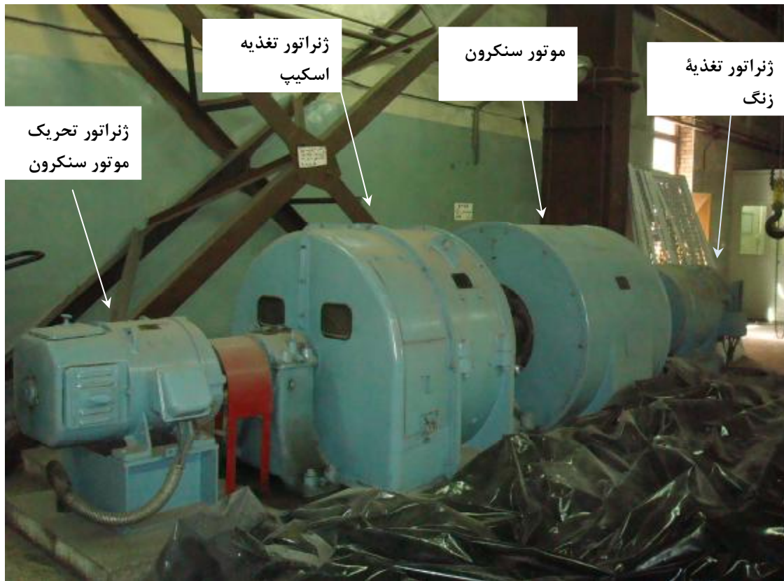
شکل شماره (2) - محل نصب سیستم موتور و ژنراتورهای قدیم کوره بلند 1 ذوب آهن اصفهان
